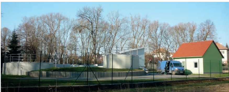
ČOV Citonice prošla kompletní rekonstrukcí
