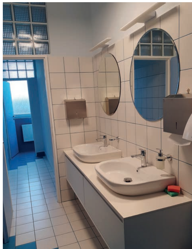
Rekonstrukce se dočkaly také toalety
