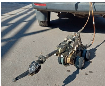
Kamerový systém připraven pro kontrolu kanalizačních přípojek – satelitní kamera
