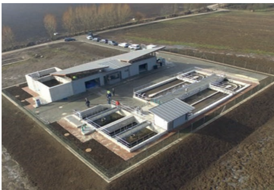
Stav před a po rekonstrukci ČOV Lysice
