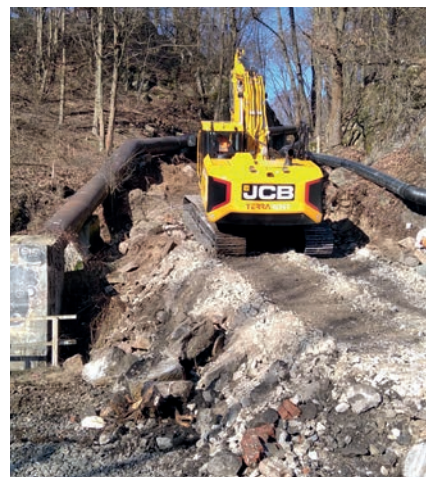
Realizace nájezdu k nadzemní části, vlevo stávající výtlak, vpravo provizorní výtlak
