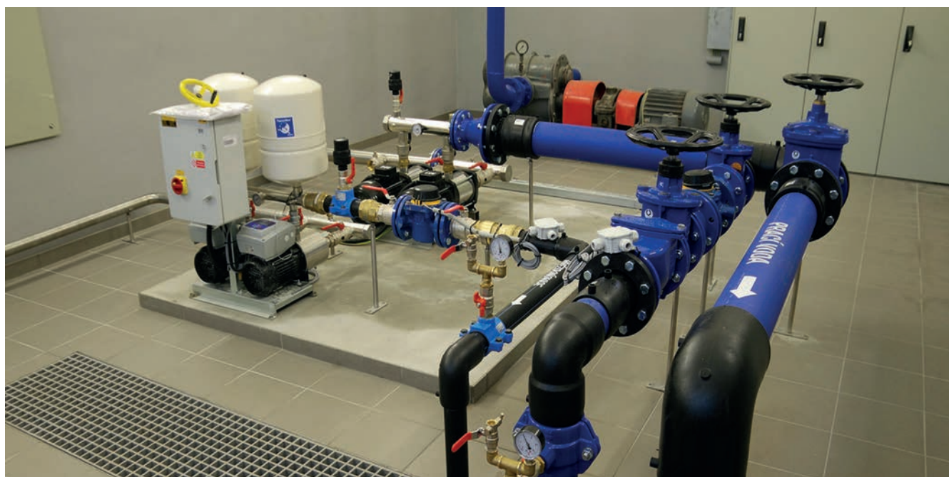
Rekonstrukce se dočkala celá čerpací stanice hvězdoňovické úpravy
