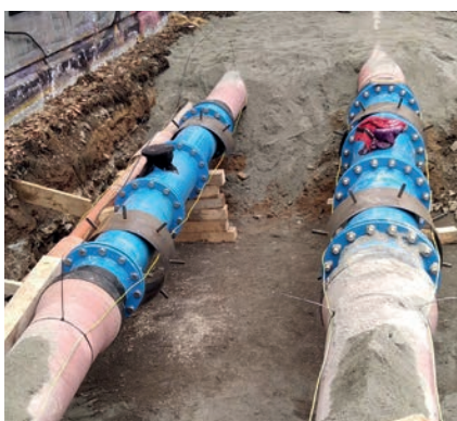
Souběh potrubí v první části stavby
