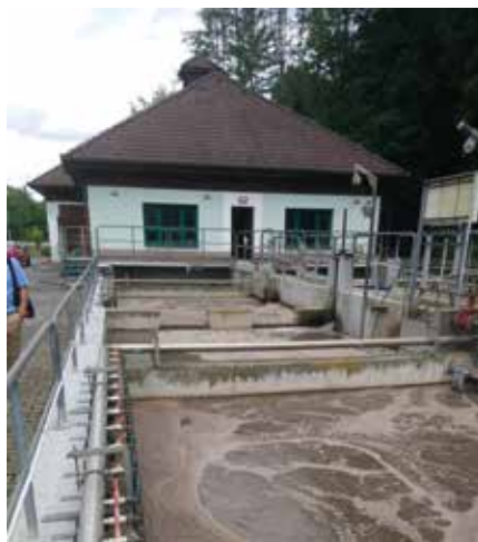
Čistírna odpadních vod Tylex před rekonstrukcí
