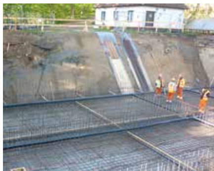
Rekonstrukce a intenzifikace čistírny odpadních vod ve Vranově nad Dyjí
