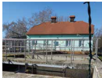
Čistírna odpadních vod Hodonice
