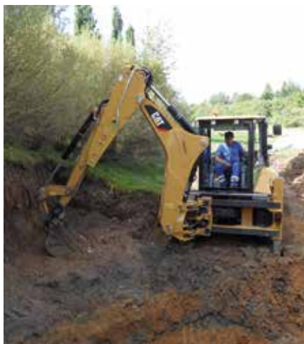
Aby mohl bagr bezpečně dosáhnout na dno výkopu, musel být snížen okolní terén o cca 2 m
