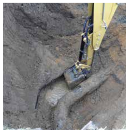
Potrubí bylo uloženo ve 4,5 m hloubce
