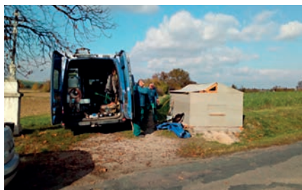
Biologický filtr instalovaný nad předávací šachtou. (Obr. 1)
