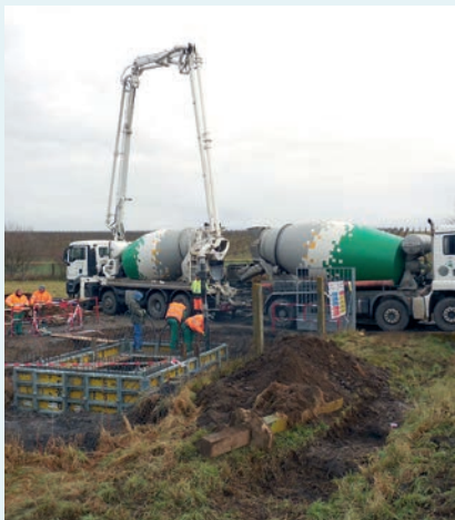
Stavba úpravní vody Loděnice
