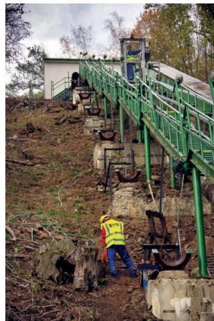
Potrubí je uloženo ve strmém svahu.
