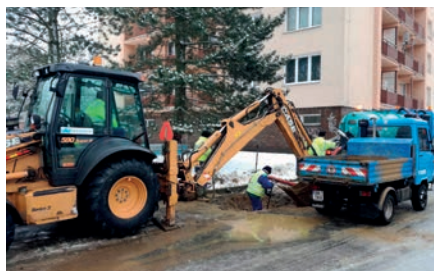
Oprava vodovodu v ulici Nad Plovárnou
