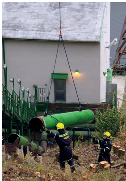
Uložit potrubí na správné místo nebylo jednoduché.
