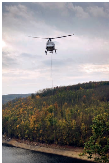
Při výměně potrubí pomáhala také helikoptéra.
