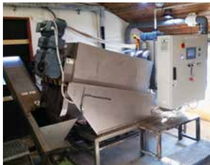
Odvodňovač na čistírně odpadních vod ve Štítarech.
