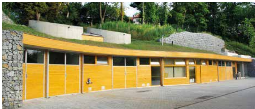
Nová čistírna odpadních vod v Náměšti.
