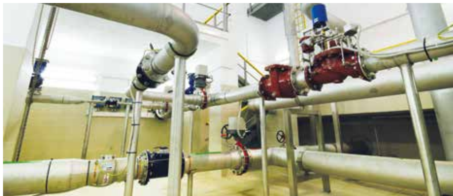
Vodojem Týn po rekonstrukci
